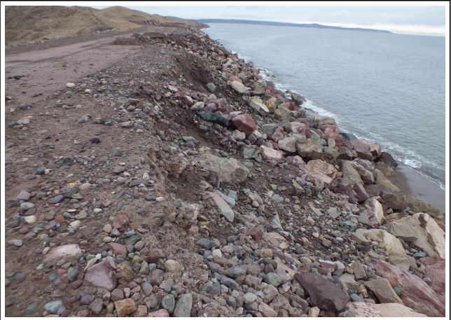
Ravines près de la digue route de la Crevasse
