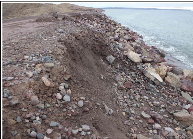
Effondrement amont avant l'effondrement devant la plateforme centrale
